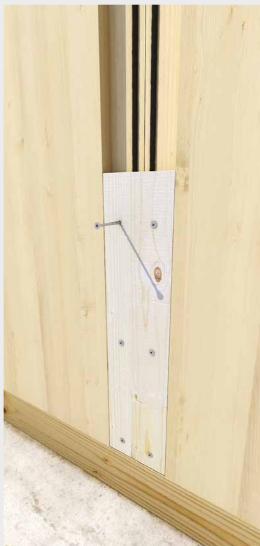
CLT panelek rögzítése 6 mm átmérőjű HBS csavarokkal. >
