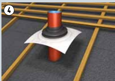
Abb. 4: PREFA Faltmanschette überziehen
