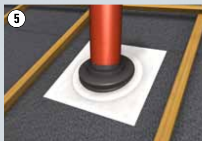
Abb. 4: PREFA Faltmanschette überziehen
