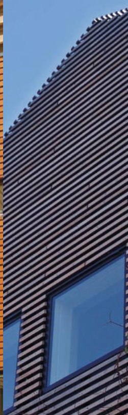
Példa: Tyvek® UV Facade nyitott hézagképzésű homlokzatnál
