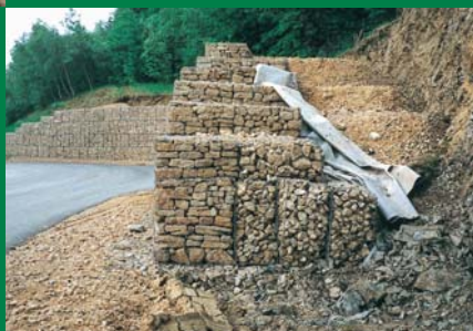
Támfalak építése (Luxembourg)
