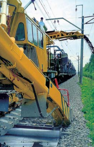
Vasúti pálya felújítás Moszkva és Szentpétervár között (Oroszország)
