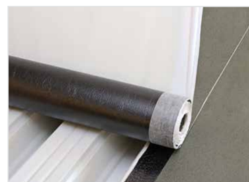
Fektetés trapézlemezre: alsó oldali fólia teljes eltávolításával.
